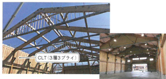
CLTの外壁(耐力壁)とフィンクトラスで18mの大スパンを実現(左)。平均天井高は9.9m。内部に耐力壁がなく、レイアウト変更が多い工場などの用途に最適。ここでは、天井ホイストクレーンも設置(右)
